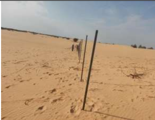
Instalación de ángulos.
