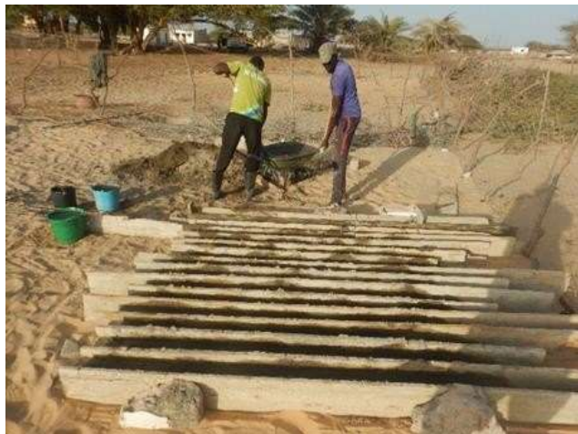
Figura 26 Preparando los postes para el vallado
