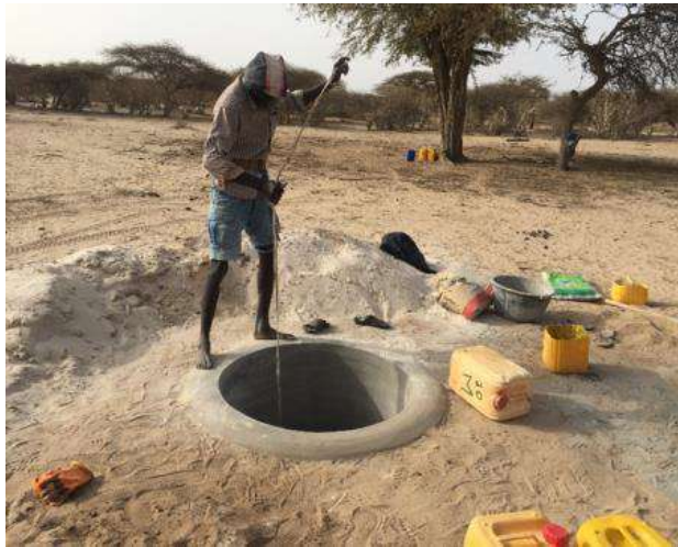
Figura 25 Usando el pozo excavado para la extracción del agua
