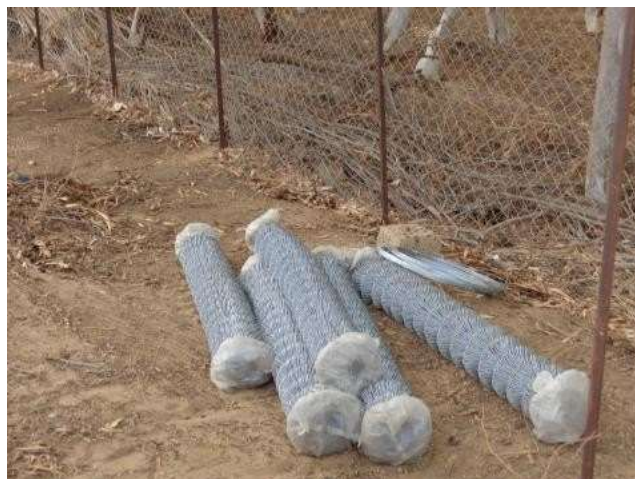
Figura 27 Malla para el vallado
