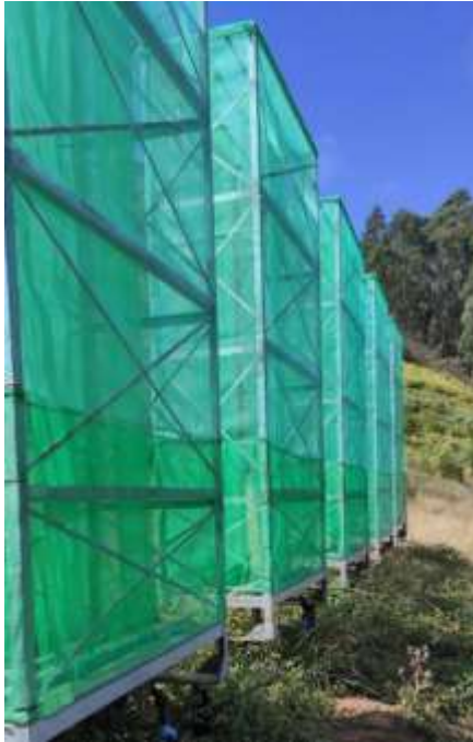
Figura 21: Captadores de niebla del modelo tradicional
